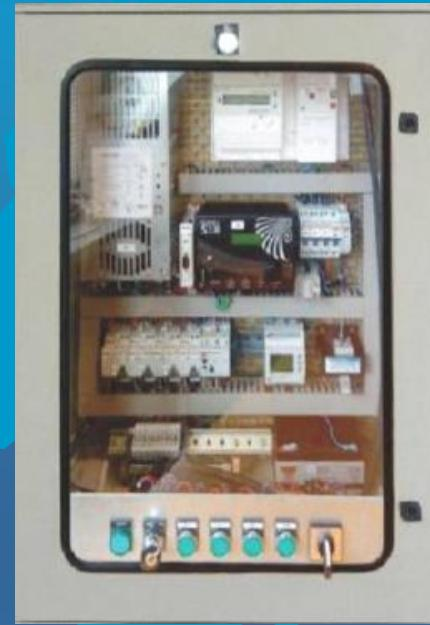
Ce système permet de gérer l'éclairage des parkings du Lycée en fonction des différents jours de la semaine. De plus, ce dispositif permet de moduler la puissance des lampes en fonction des heures de la nuit.
